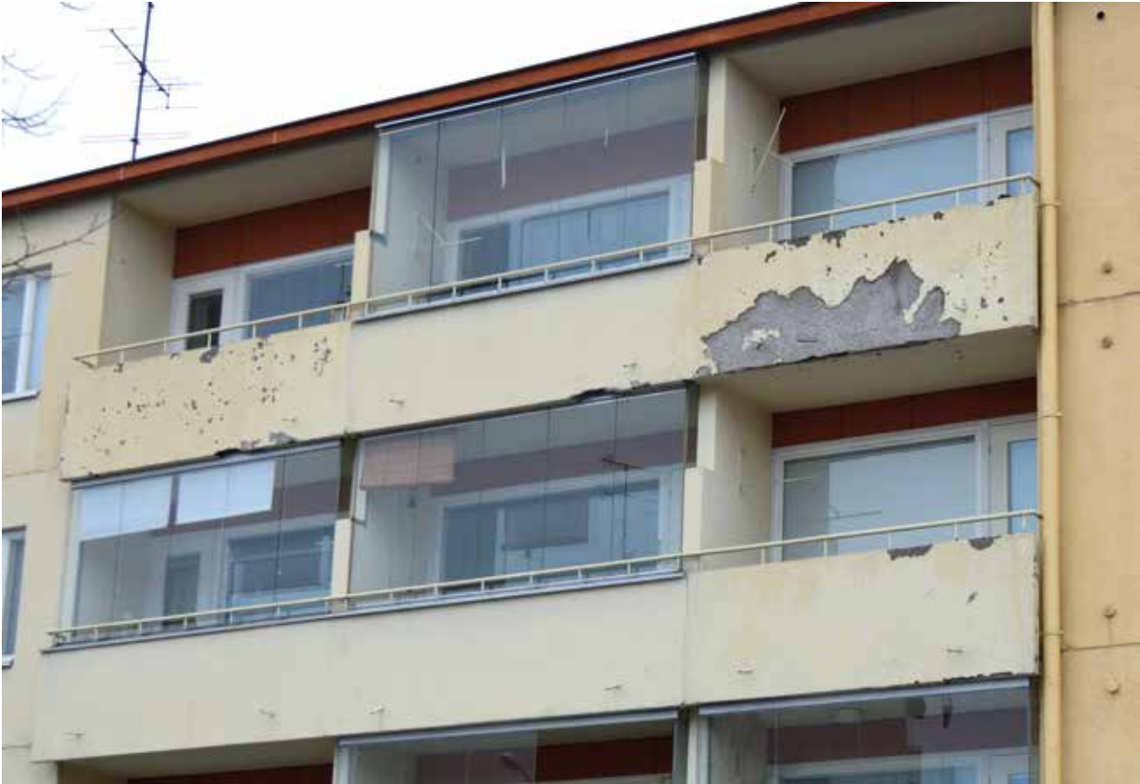
Kuva 3: Lasitettu parveke suojaa parvekerakenteita turmeltumisilmiöiltä, kuten kuvan kaiderakenteista voidaan hyvin havaita.
