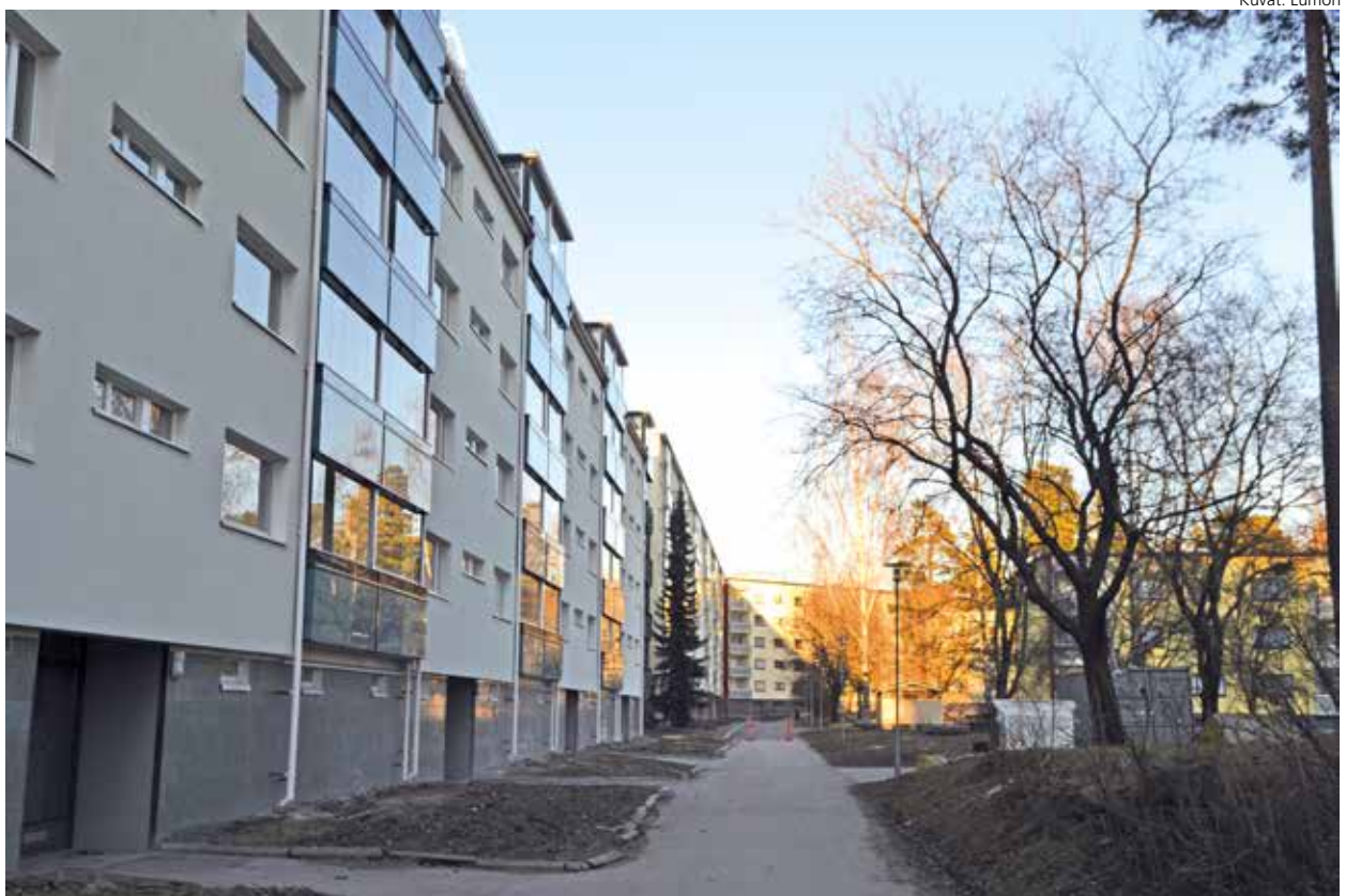
Kuva 2: Lasi-alumiinirakenteet ovat suosittuja ratkaisuja lähikerrostalojen julkisivuja korjattaessa ja uudistettaessa. Parveke säilyy rakennusoikeuteen kuulumattomana ulkotilana lasittamisen jälkeenkin.
