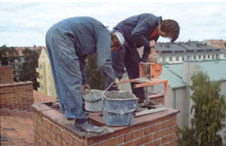
Kuva 7. Peltimadon torjuntaa. Matolääkettä kaadetaan muuratun hormin kautta taloon.
