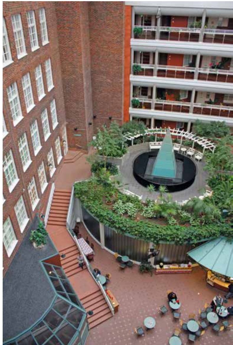
Turun Verkahovin asunnot sijaitsevat vanhassa tekstiilitehtaassa. Sisäpiha on toteutettu samantyyppisesti kuin valmistuvassa Wärtsilän kohteessa.
