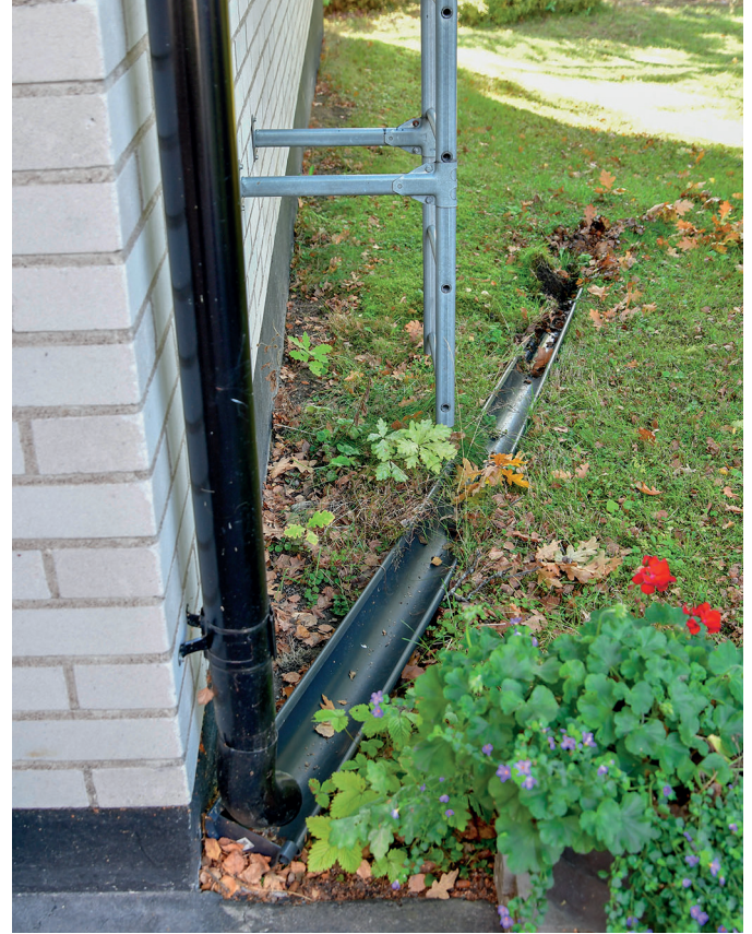
Sadevedet on johdettu omalle tontille niin sanotun sivuheiton avulla.
