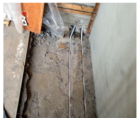
Myös lattian alapuolinen rakenne on tehty betonista. Radiaattorien jätevesi kulkee kahden ohuen putken läpi ulkoseinää pitkin, tarkoituksenaan estää kosteutta kondensoitumasta lattian alle.
