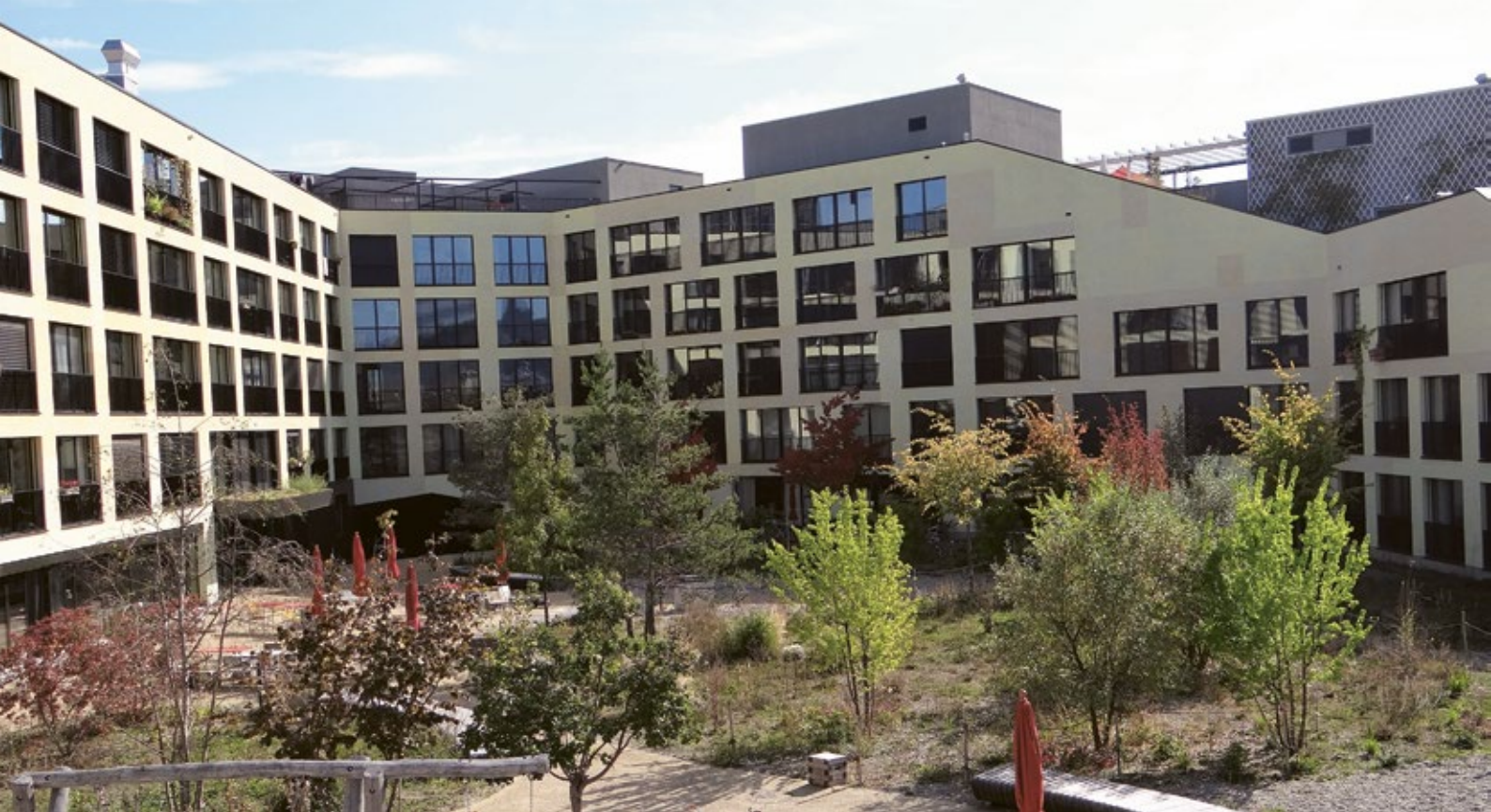
Kalkbreiten sisäpihalle nouseaan katutasolta jyrkkiä portaita pitkin. Pihakannen alta löytyy raitiovaunuhalli.
