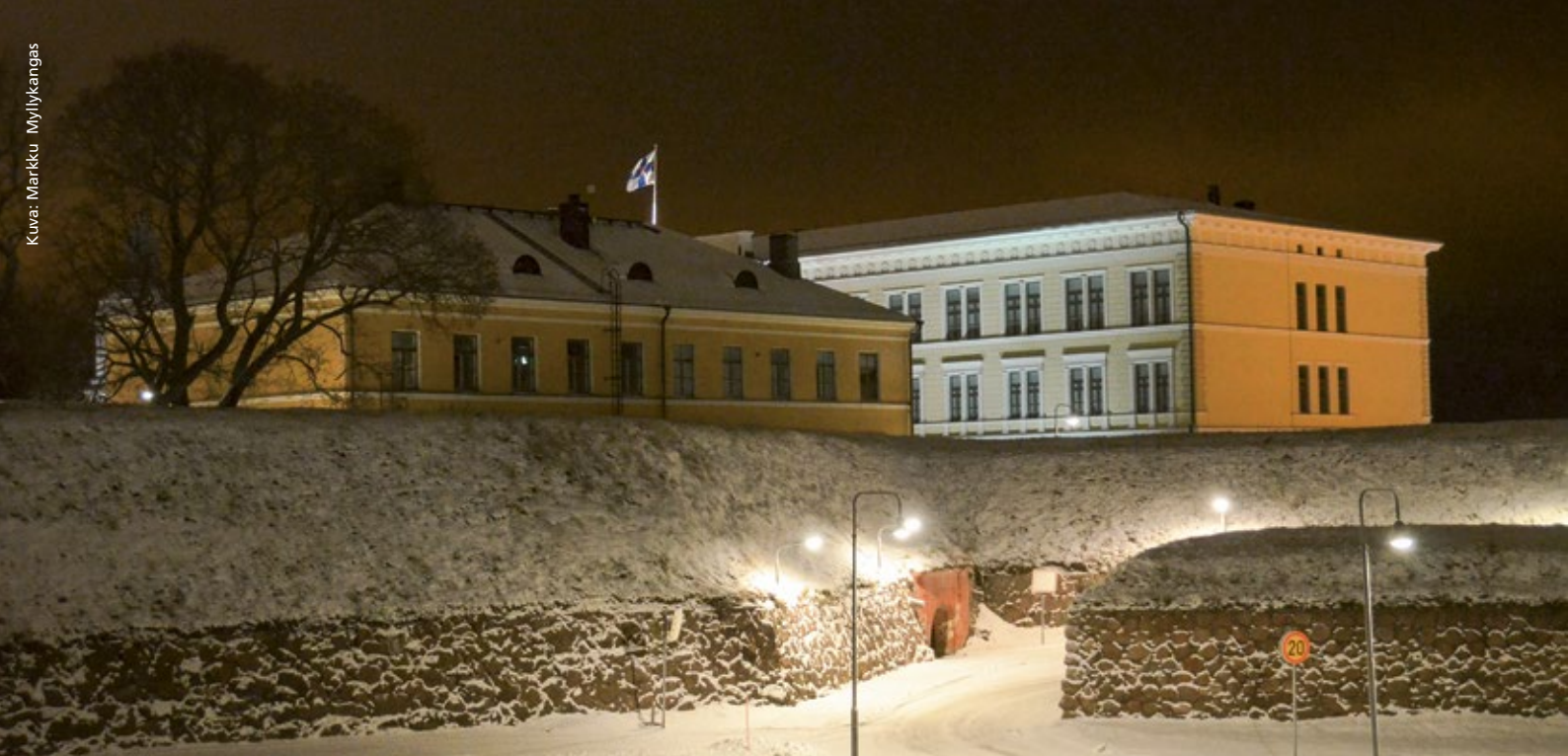
Haminan linnoitus ja Bastioni muodostavat vaikuttavan kokonaisuuden yhdessä Reserviupseerikoulun rakennusten kanssa.
