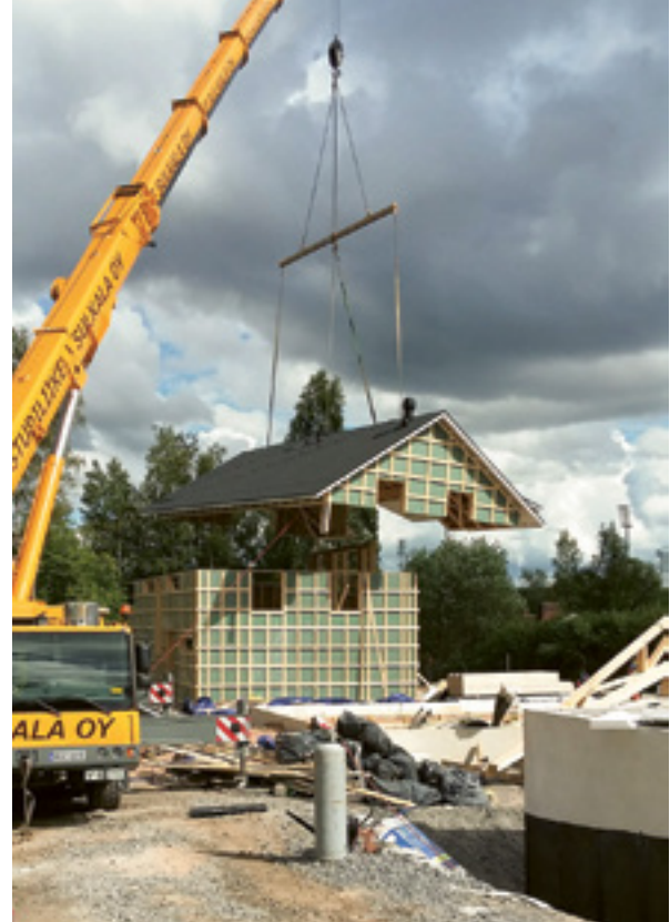
Valmis katto tarjoaa nopean suojan lopulle rakennukselle.
