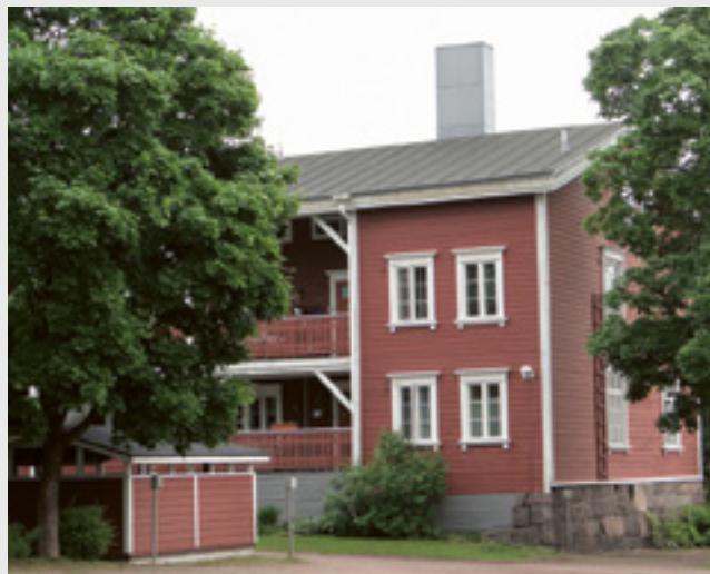
Ns. Norjan sahan sivukäytävällisistä työväen kasarmeista on säilynyt kaksi.
